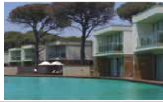
SEMBOL İNŞAAT - RIXOS BELEK
