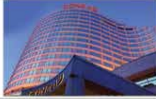
AKSOY İNŞAAT - CONRAD OTEL
