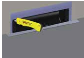
Maket bıçağı ile iç boşluktan bandı kesiniz. Cut the butyl band from the interior space with the utility knife.
