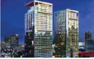
BAY İNŞAAT - MASLAK 42
